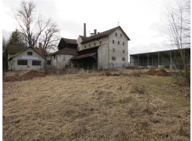
Abb. 5: Aufnahme 2017: Blick auf die verfallenen Brauereigebäude, von Osten
