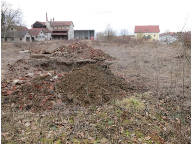
Abb. 4: Aufnahme 2017: Blick von Süden nach Norden, im Westen die ehem. Brauereigebäude, rechts vorh. Wohngebäude 505
